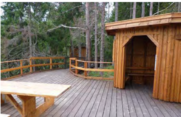
Bild 27: Plattform med vitaskydd, Steningedalsens naturreservat, Västernorrlands län. Foto: John Granbo
