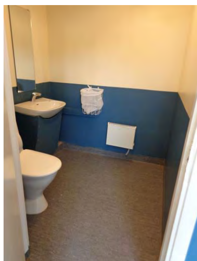
Bild 17: Den anpassade toaletten är inte så anpassad.
