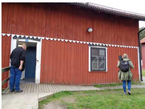
Bild 15: Ramp in till toaletter. Några små åtgärder och den är som ny.
