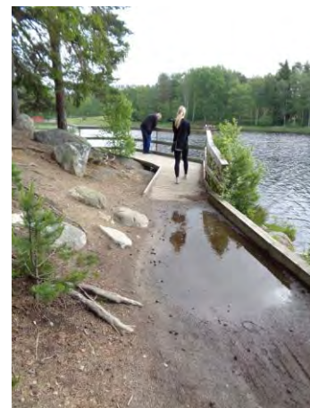
Bild 22: Bredda stigen och åtgärda försänkningen.
