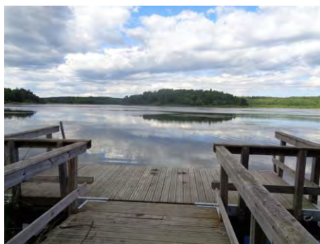
Bild 37: Brygga i södra änden saknar avåkningsskydd.
